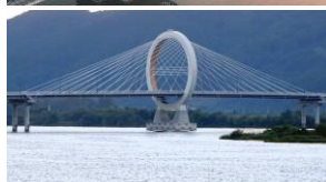
2017 Chuncheon Leg- oland Bridge, Gangwon, Dél-Korea
